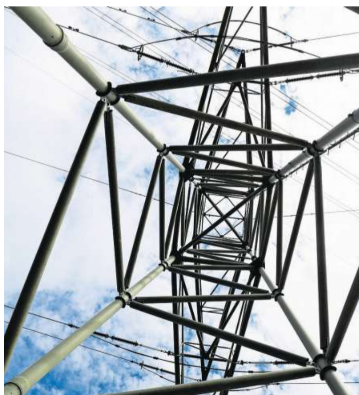
Unklare Aussichten: Strommast in Niedergösgen.
